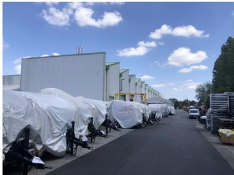
Foto 12 – corpo “B” – oggetto di ampliamento
