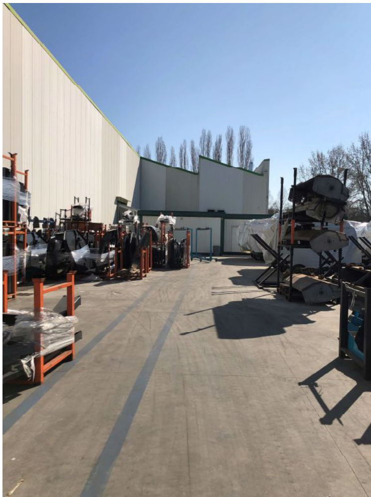
Foto 6 – corpo “B” –oggetto di ampliamento
