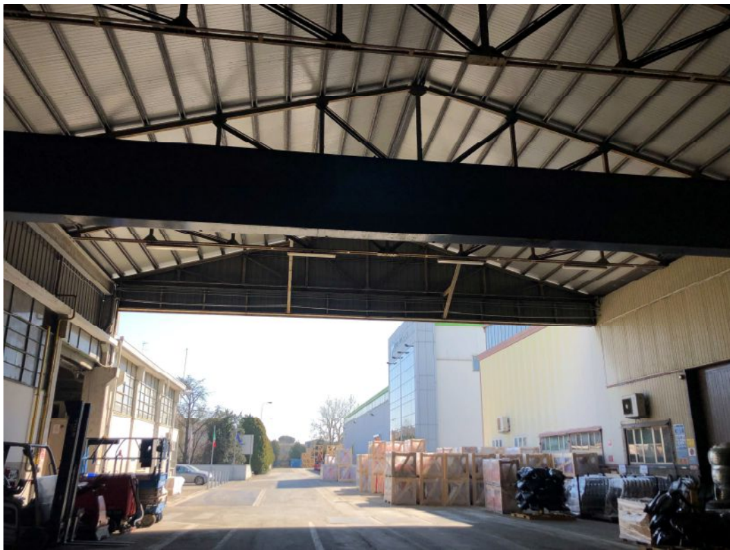
Foto 4 – tettoia corpo “A” – non oggetto di intervento
