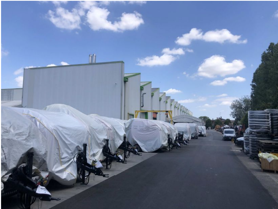
Foto 12 – corpo “B” – oggetto di ampliamento
