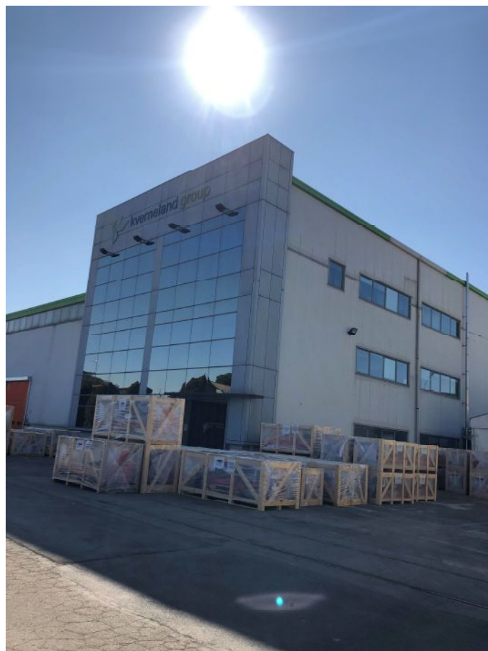
Foto 10 – corpo “B” – oggetto di ampliamento
