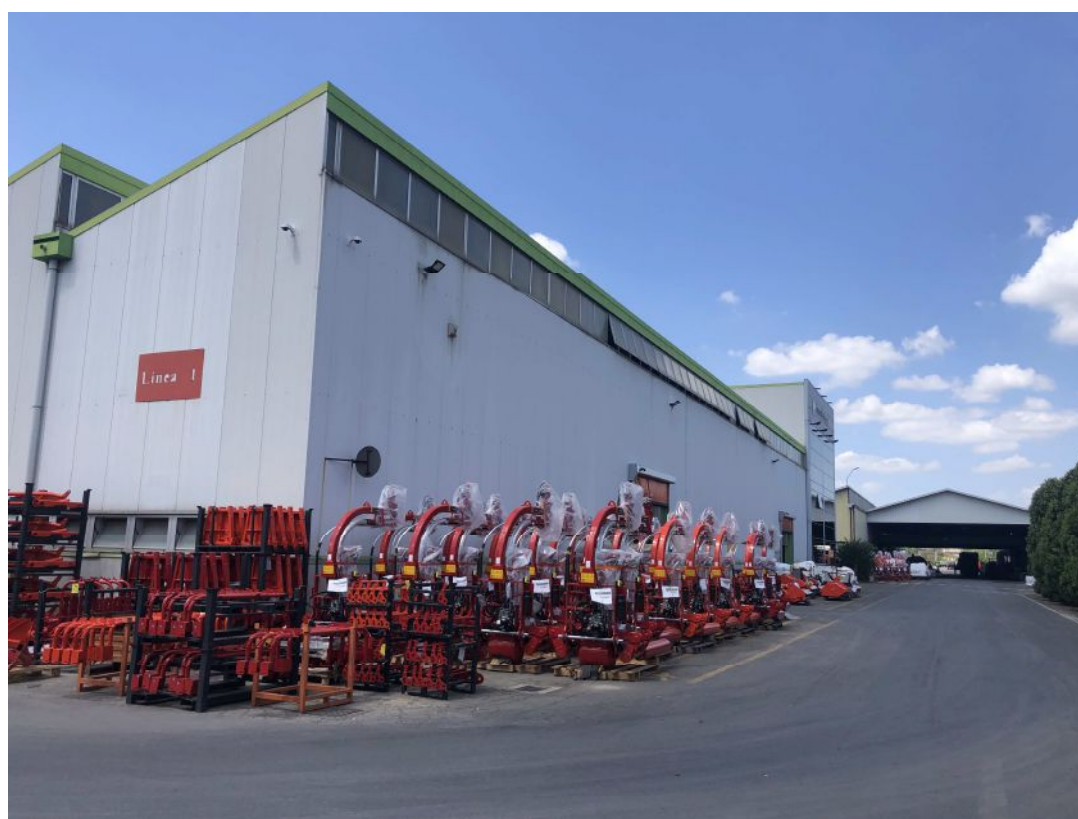
Foto 11 – corpo “B” – oggetto di ampliamento
