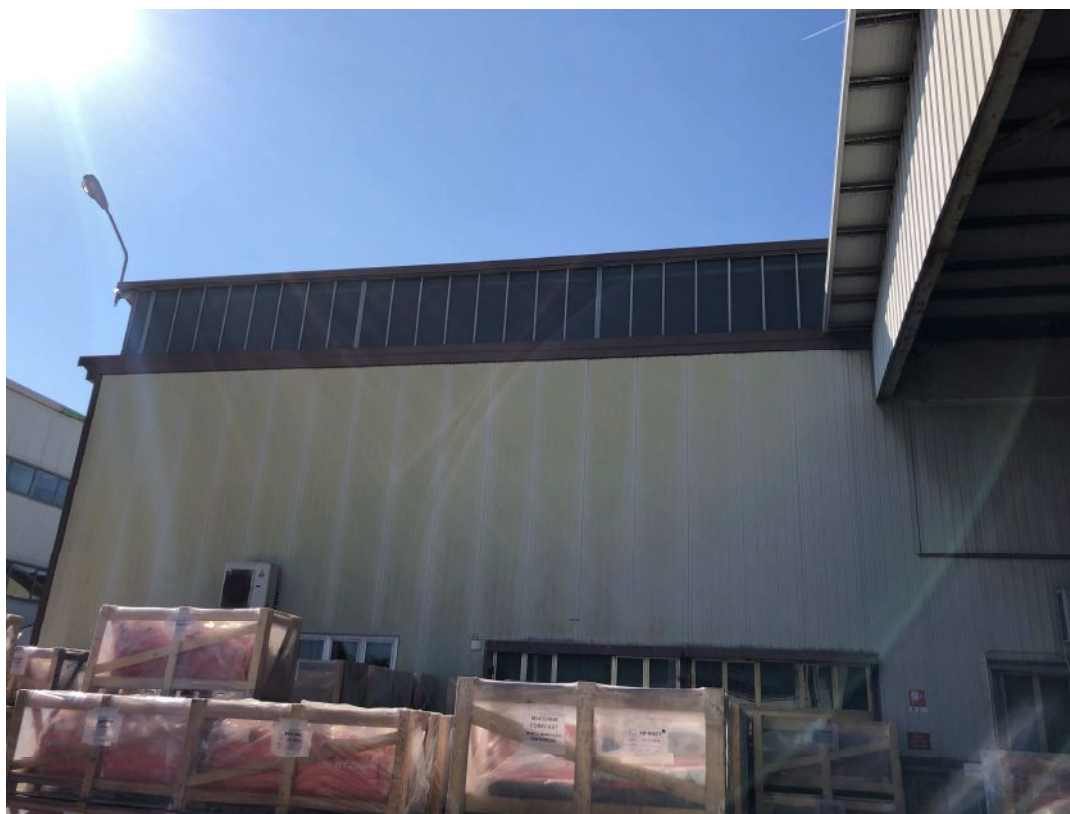
Foto 9 – corpo “B” – oggetto di ampliamento
