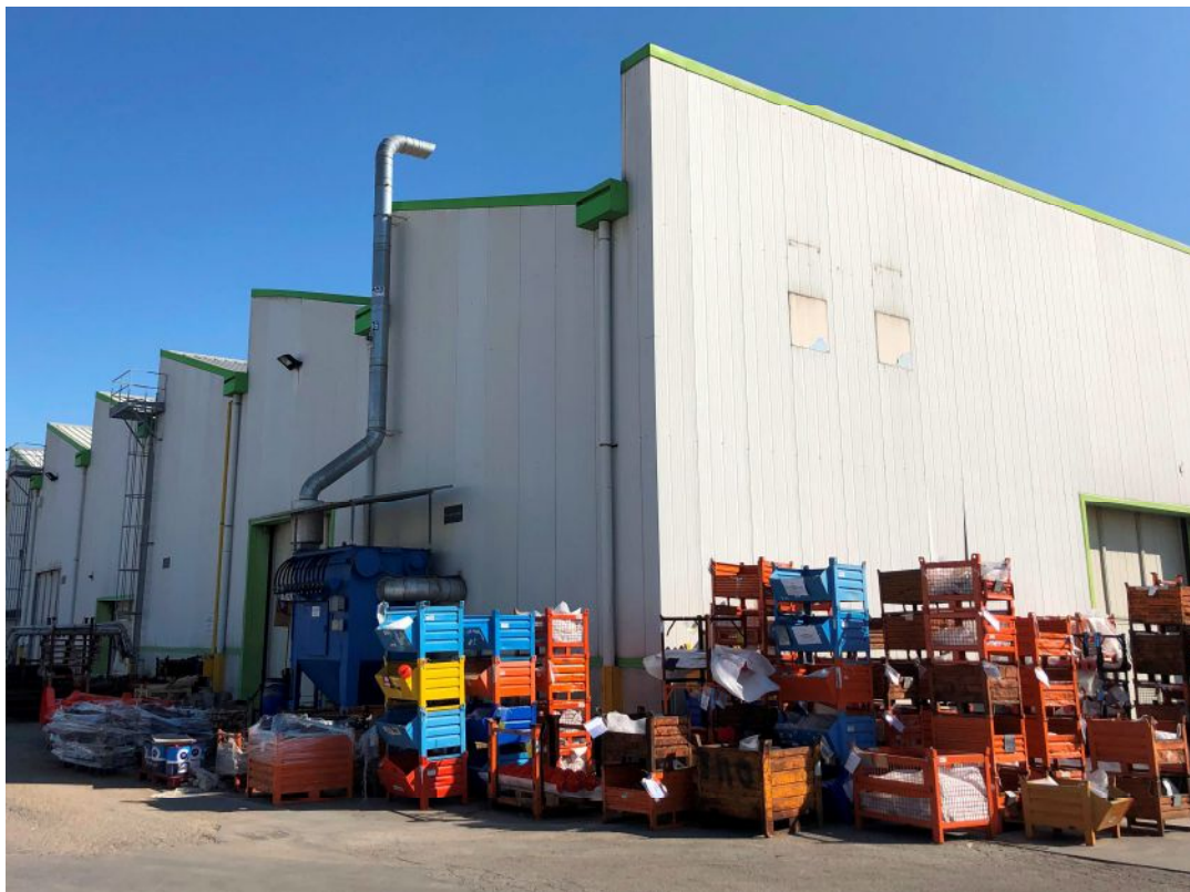
Foto 7 – corpo “B” –oggetto di ampliamento
