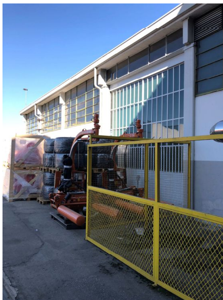
Foto 3 – corpo “A” – non oggetto di intervento
