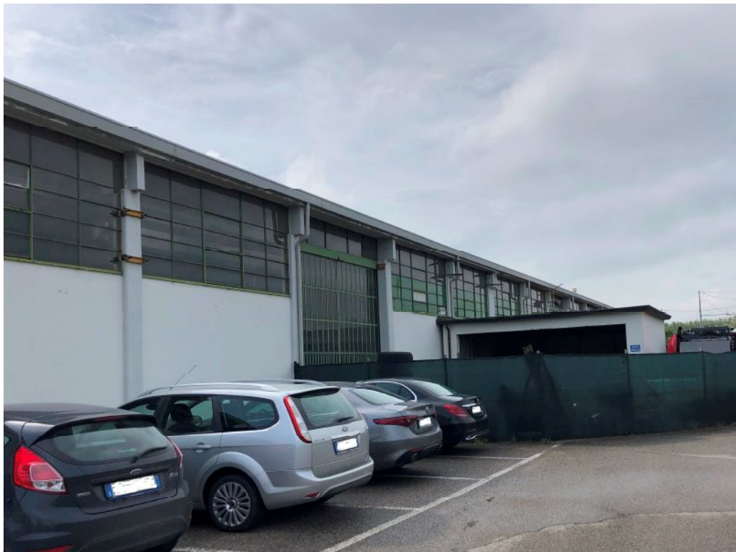
Foto 2 – corpo “A” – non oggetto di intervento
