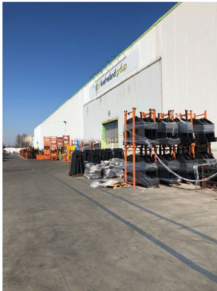
Foto 5 – corpo “B” – oggetto di ampliamento
