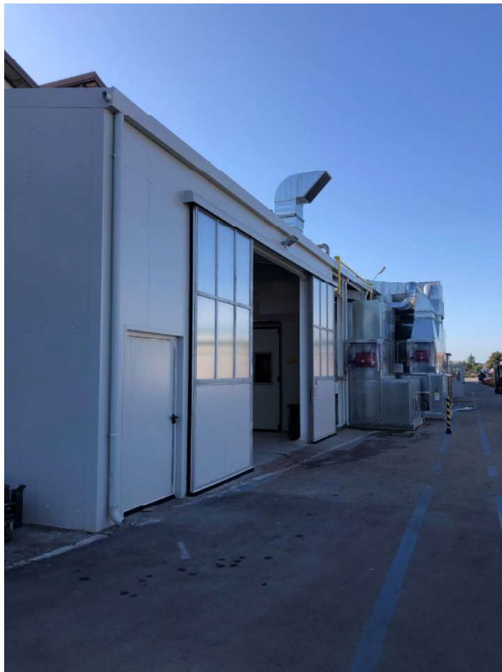
Foto 8 – corpo “B” – tettoia/cabina di verniciatura
