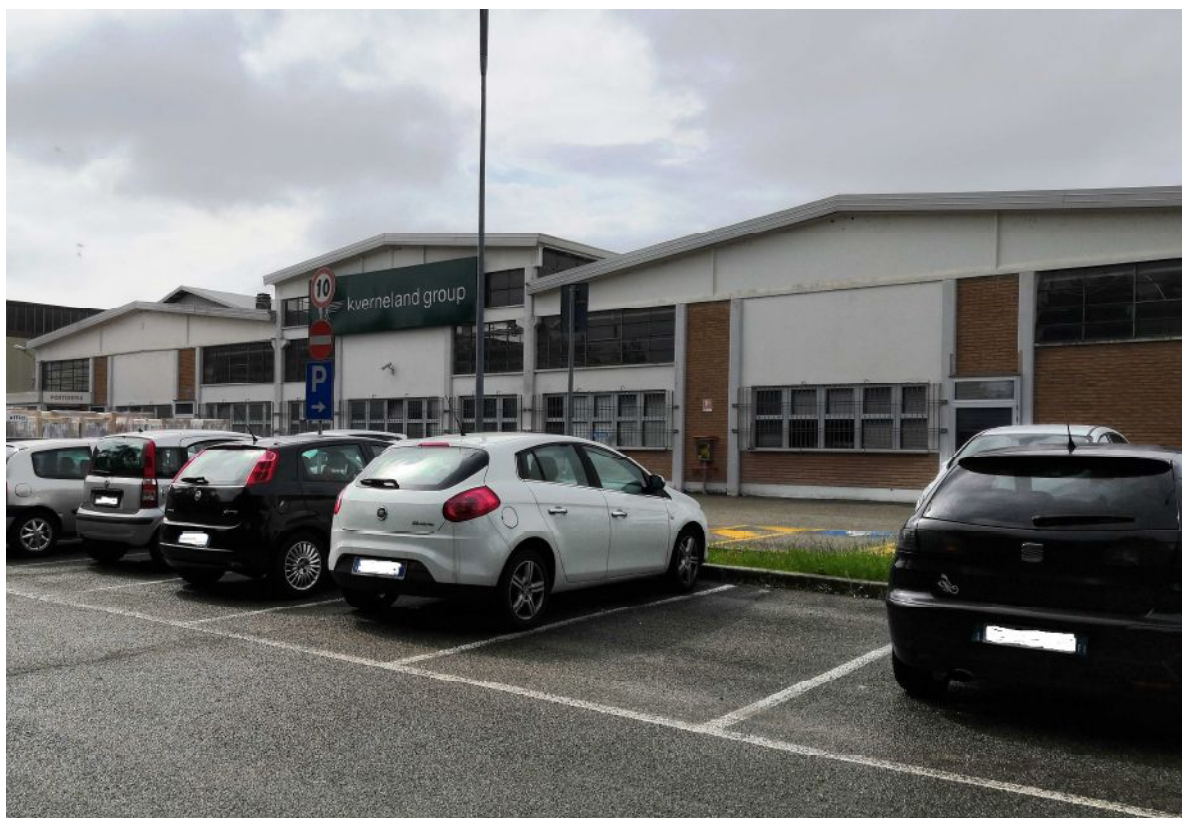
Foto 1 – corpo “A” – non oggetto di intervento
