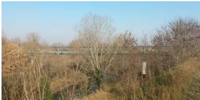
Immagine dell'attraversamento aereo esistente
