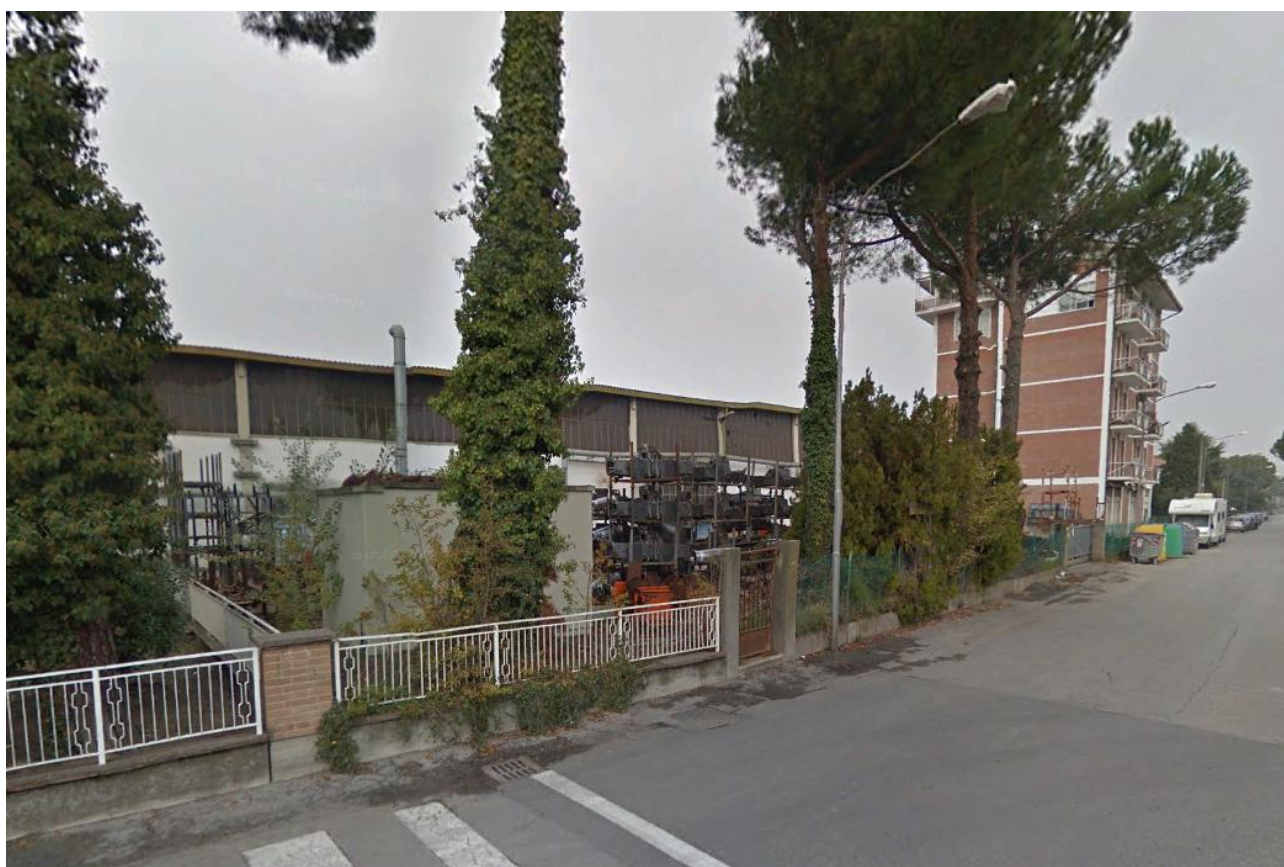
FOTO F-3: VISTA DELLO STABILIMENTO ATTUALE DAL PUNTO DI COORDINATE 263263.09 M E 4917867.51 M N.
