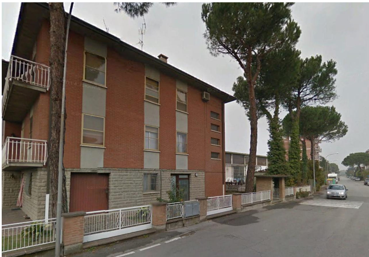
FOTO F-2: VISTA DELLO STABILIMENTO ATTUALE DAL PUNTO DI COORDINATE 263240.77 M E 4917832.55 M N.
